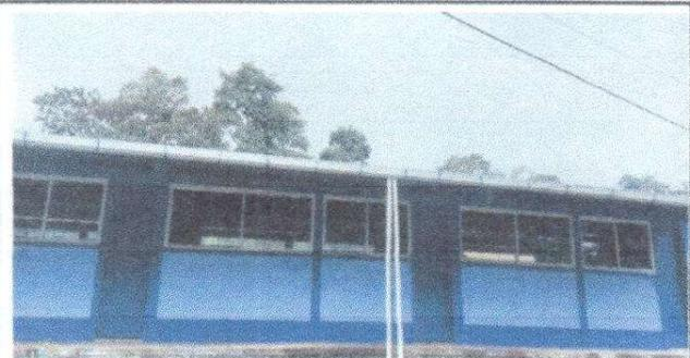
Foto 4: Se sustituyeron Canales y Bajadas de Aguas Pluviales
